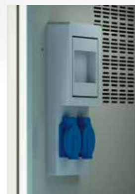
Prese 2 × 230 V/16 A con coperchio, 1×interruttore ID/IM per scomparto
